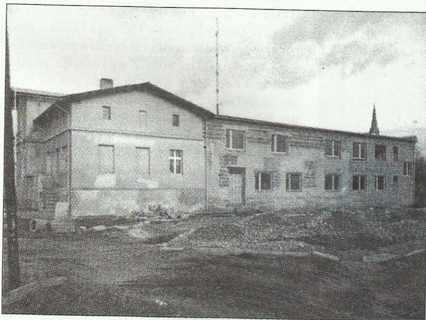
Urząd w trakcie rozbudowy.
