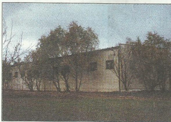
Stacja wodociągowa w Białymkale.
