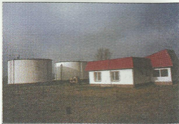
Siedziba „Wodociągi Gminne”
