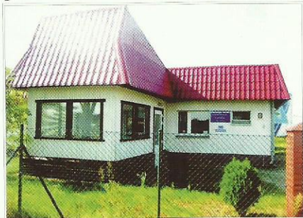
Siedziba Spółki „Wodociągi Gminne”
