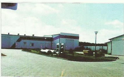
Nowe zaplecze techniczno-socjalne.
