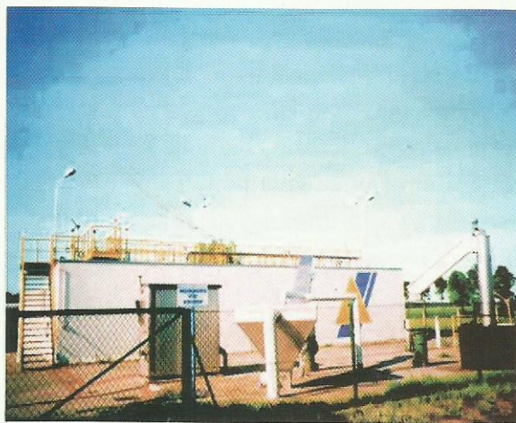
Zmodernizowana oczyszczalnia ścieków w Chojnie
