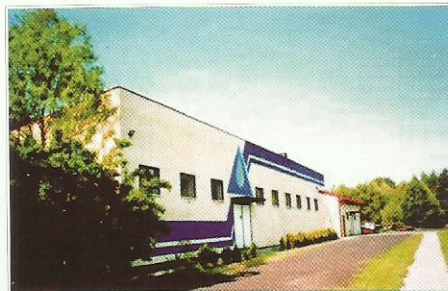
Stacja wodociągowa w Białymkale
